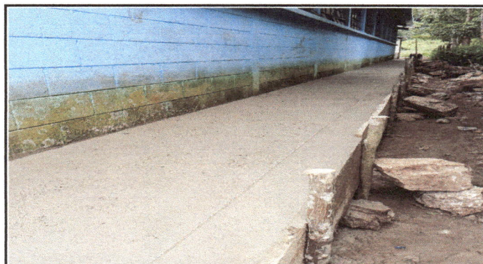
Foto 3: Modulo 2. Evidencia de los trabajos del mejoramiento de la base perimetral en donde se utilizo, hierro de 3/8 y 1/4.
