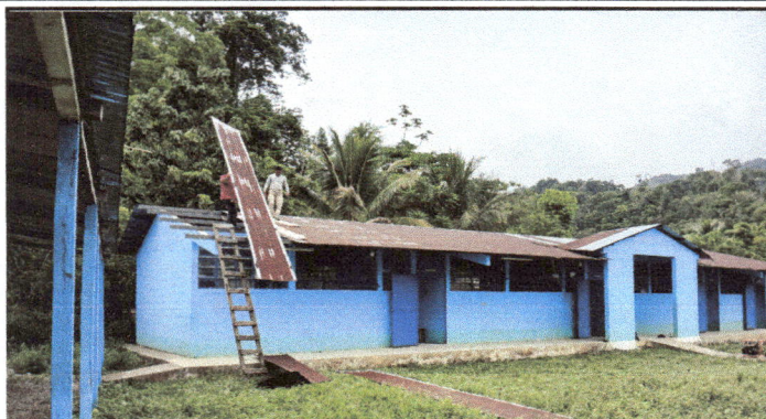
Foto1: Evidencia del Modulo No 1. CUBIERTA DE LAMINAS 21X16 fue sustituidas por laminas troqueladas color blanco calibre 26.
