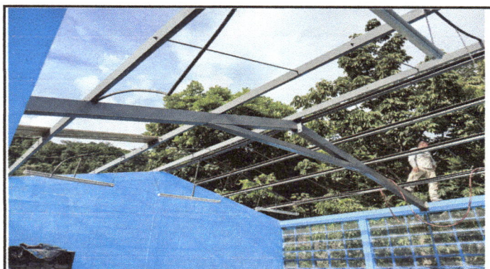
Foto 4: MODULO 3: MANTENIMIENTO DE LA ESTRUCTURA DE TECHO con pinturas de color gris de secado rapido.
