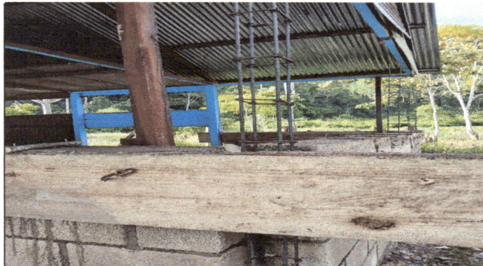
Foto 3: Modulo 5 fotografia de los trabajos para la colocacion de los blocks de poma.
