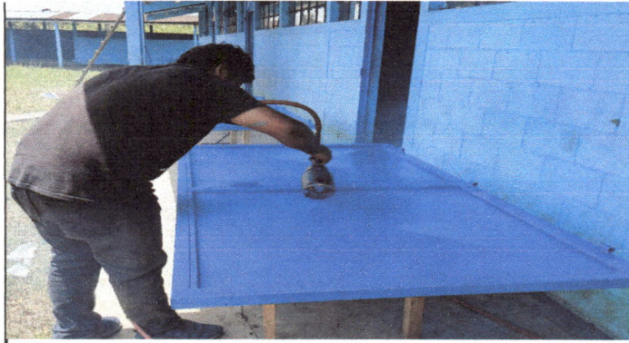
Foto1: Modulo 4. Evidencia de la pintada de las puertas con color azul de Secado rapido.
