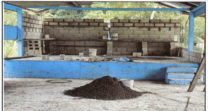
Foto 2: Modulo 5: Colocacion de 250 block para el mejoramiento del salon del Instituto Nacional de Educacion Basica la cual fue apoyada por parte de los padres de familia.
