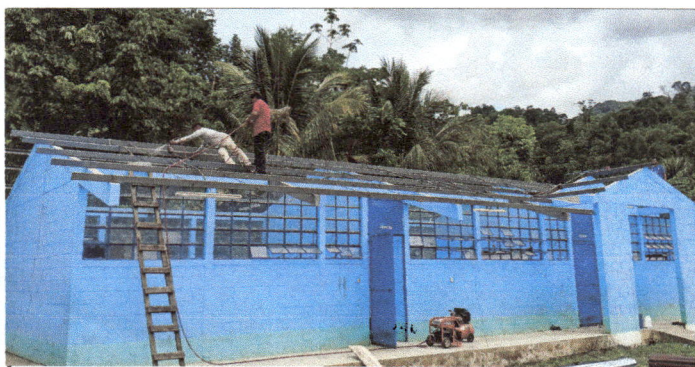
Foto 5: fotografia de la pintura de la Estructura de Techo con la pintura Gris de secado rapido.
