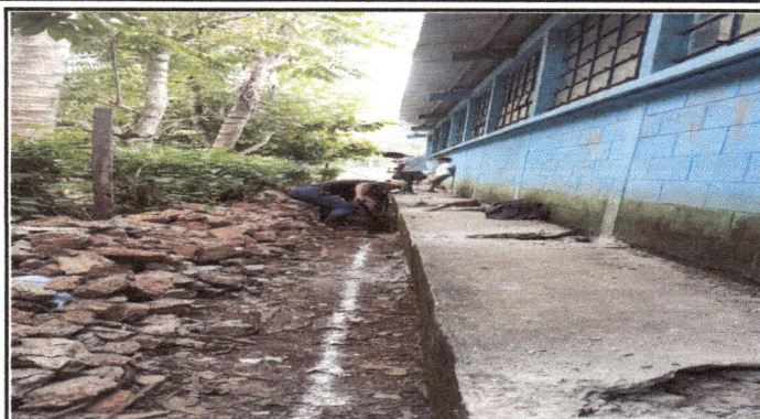
Foto 2: Modulo 2 fotografías de los del Mejoramiento de la base perimetral de 80 de profundidad y 83 de ancho por 8 metro de la esquina.
