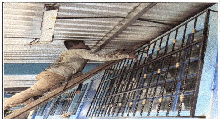
Foto 4: MODULO 6: Colocacion de los valcones en la dirreccion del centro educativo de 2.30x1.50 y de 2.80x 1.50
